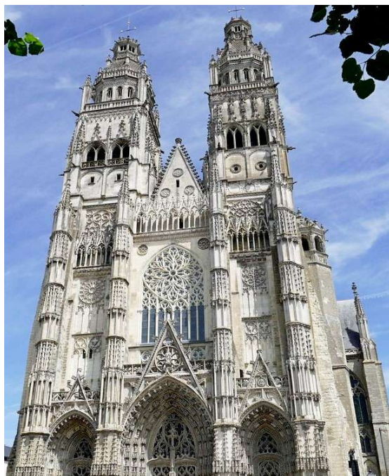
Façade ouest de la cathédrale Saint-Gatien de Tours, France (entre 1430 et 1470, rose de la fin du XI e siècle, les tours et ses clochers sont du début du XVI e siècle)
