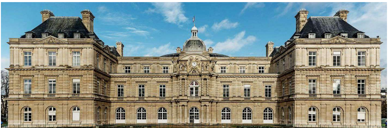
Façade sur jardin du Palais du Luxembourg à Paris, en France, conçu par Salomon de Brosse (à partir de 1615) Source : https://www.wikiwand.com/fr/Palais_du_Luxembourg#/media/Fichier:Palais_du_Luxembourg,_South_View_(Crop)_20140116_1.jpg
