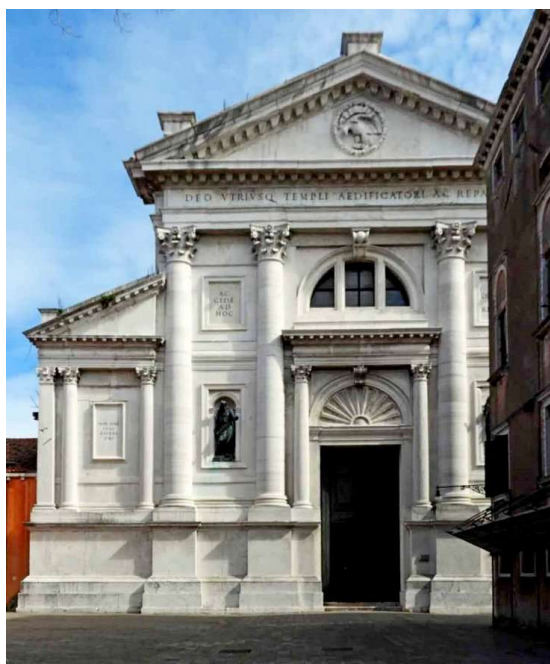
Andrea Palladio : la façade de l'église San Francesco della Vigna à Venise, Italie (vers 1570) Source de l'image : http://carnetvoyagesbf.canalblog.com/archives/2019/03/27/37212830.html
