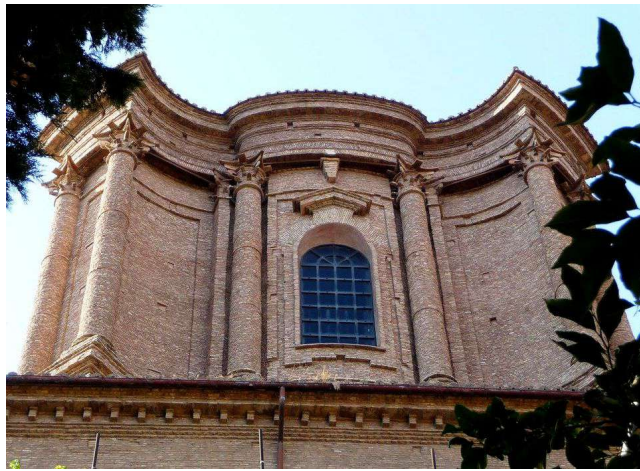
Francesco Borromini : l'un des quatre pans de la tour formant l'extérieur du dôme de la basilique Sant'Andrea delle Fratte à Rome (1653 à 1667)
