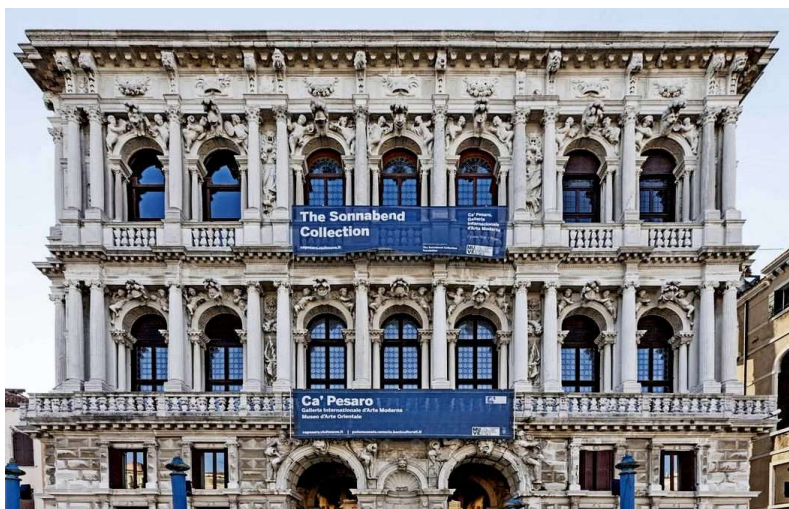
Baldassare Longhena : détails de la façade du Ca' Pesaro à Venise (1659-1682)
