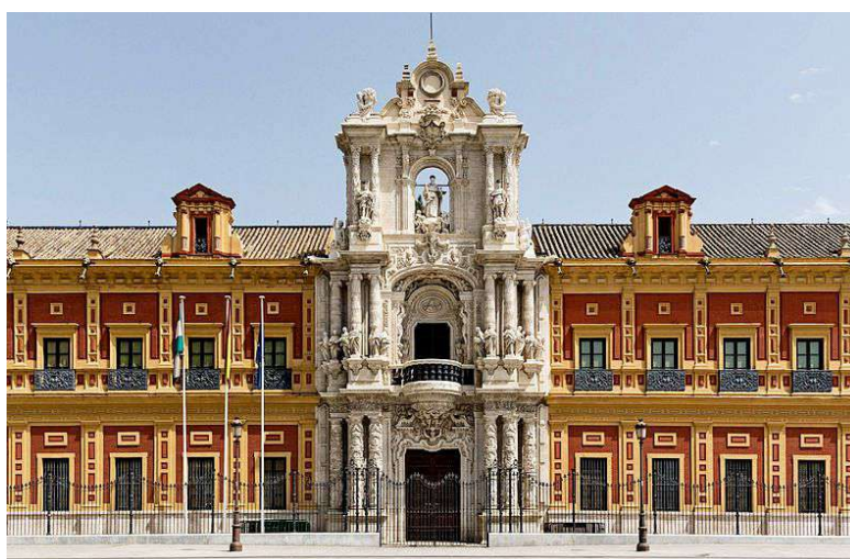
Leonardo de Figueroa : détail de la façade principale du Palais de San Telmo à Séville, Espagne (1682-1734)
