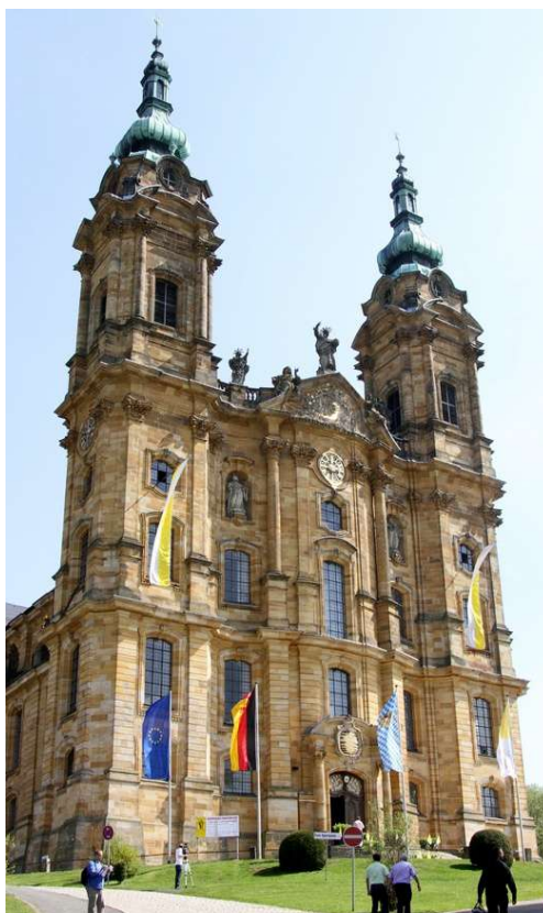
Johann Balthasar Neumann : façade de la Basilique de Vierzehnheiligen près de Bad Staffelstein en Allemagne (1743-1772)
