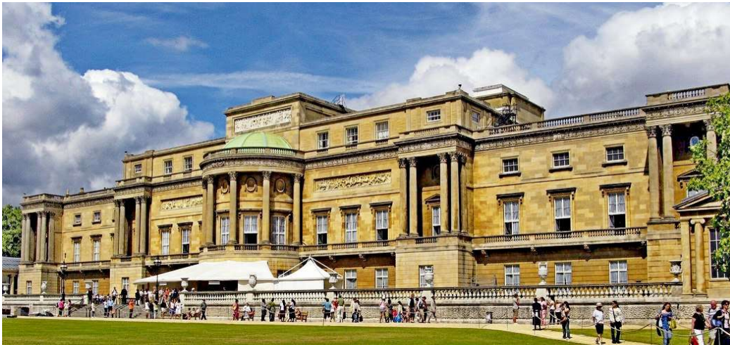
John Nash : façade arrière du palais de Buckingham à Londres, Angleterre (1782- 1792)
