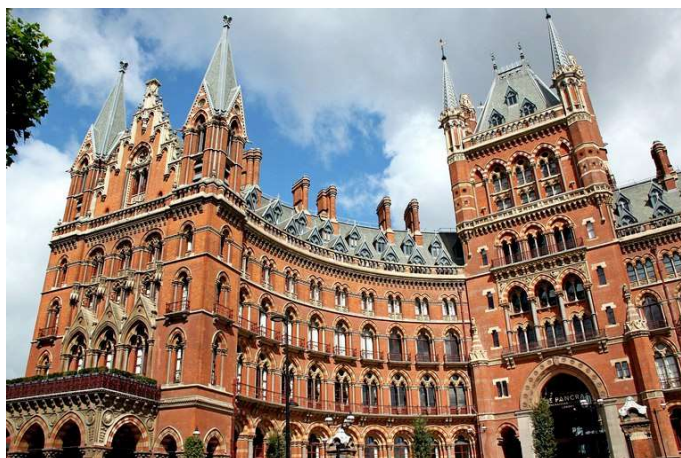
Sir George Gilbert Scott : l'ancien Midland Grand Hôtel, St. Pancras Station à Londres, Angleterre (1866-1876)
