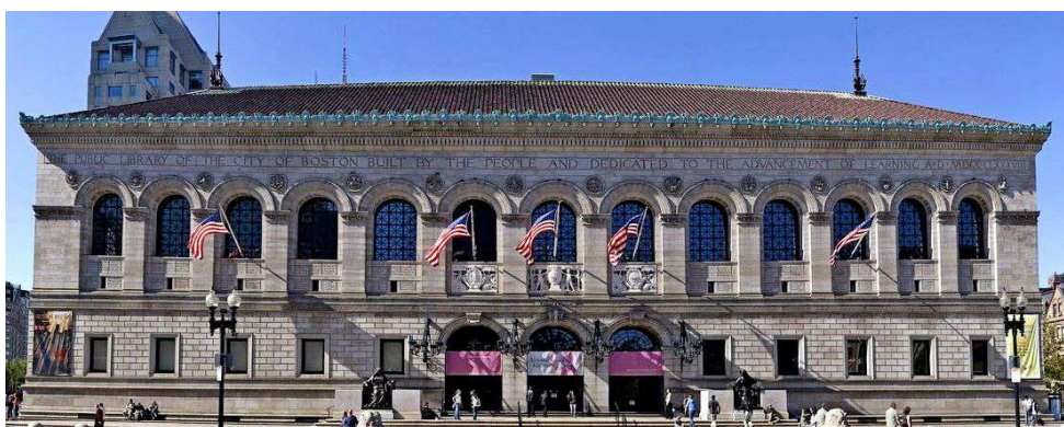
Agence McKim, Mead & White : bibliothèque publique de Boston (dit McKim Building), USA (ouverte en 1895)
