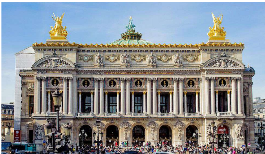
Charles Garnier : à gauche, la façade de l'Opéra Garnier à Paris, France (1861-1875) ; ci-dessous, croquis initial de Garnier sur lequel l'attique est en retrait de la façade
