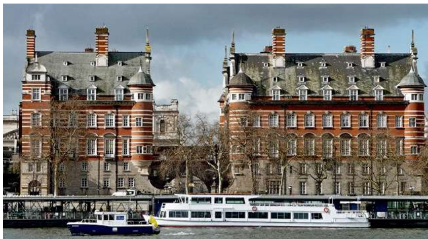
Norman Shaw et John Dixon Butler : les Norman Shaw Buildings (anciennement New Scotland Yard) à Londres, Angleterre (1887-1906)
