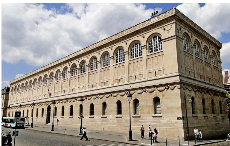
Henri Labrouste : façade et pignon de la bibliothèque Sainte-Geneviève à Paris, France (1843-1850)
