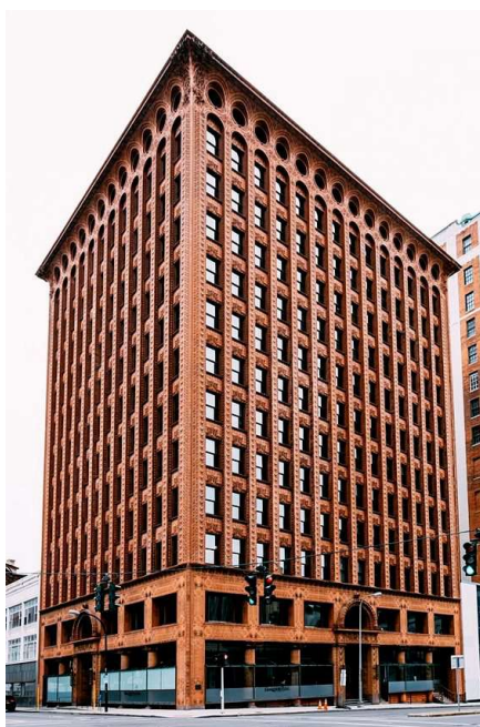
Louis Sullivan avec Dankmar Adler : Guaranty Building (anciennement Prudential Building) à Buffalo, État de New York, USA (1896)
