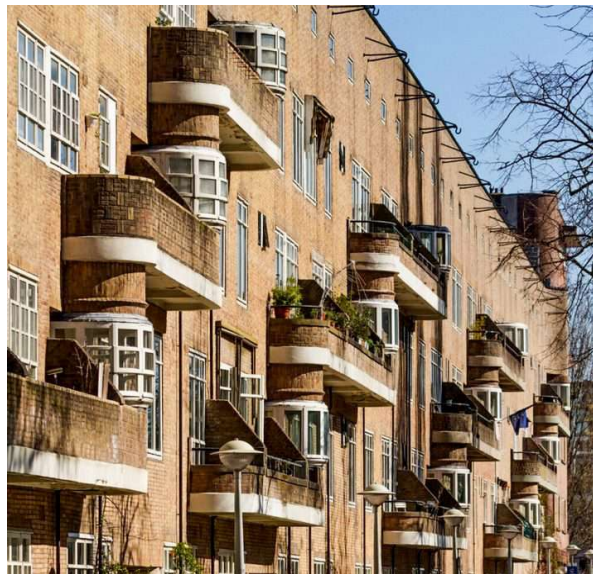
Michel de Klerk : façade d'un immeuble de l'avenue Vrijheidslaan à Amsterdam, Pays-Bas (1921-1923)
