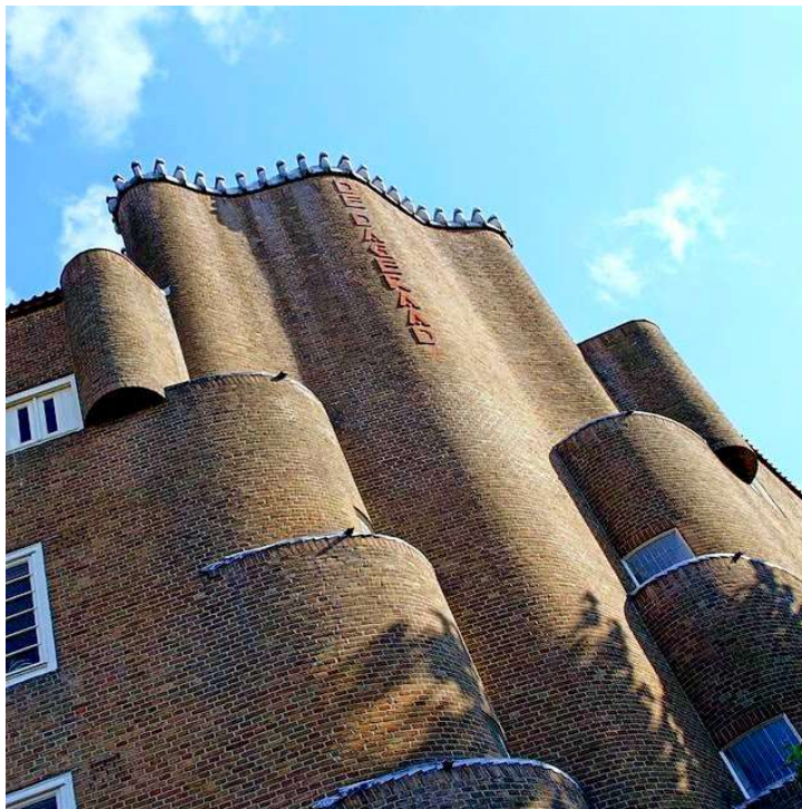
Piet Kramer : 130 Burgemeester Tellegenstraat, détail de l'ensemble de logements De Dageraad (L'Aube), construit avec Michel de Klerk à Amsterdam, Pays-Bas (1910-1913)
