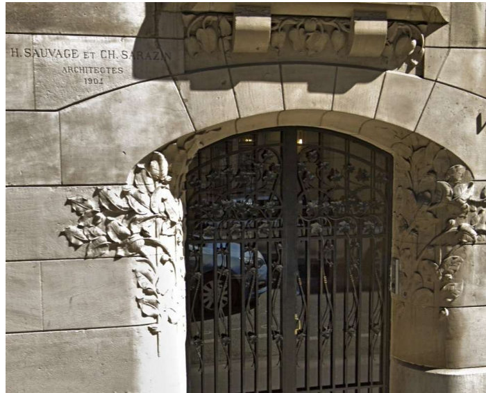
Henri Sauvage avec Charles Sarazin : détail de l'entrée d'un immeuble au 22 rue Laugier à Paris, France (1901)
