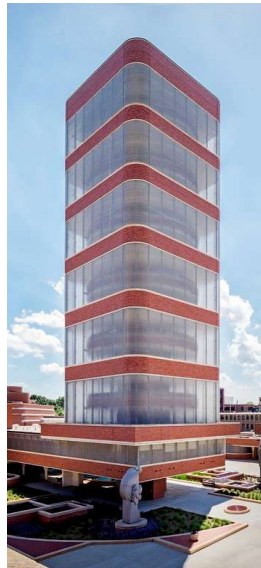
Frank Lloyd Wright : la tour du laboratoire de recherche de la société Johnson à Racine dans le Wisconsin, USA (1950).
