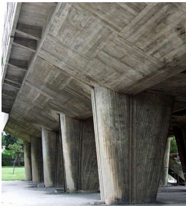
Le Corbusier : à gauche, pilotis de la Cité Radieuse de Marseille, France (1947-1952) ; Ci-dessous, détail de la façade de la chapelle Notre-Dame-du-Haut à Ronchamp, France (1953-1955)
