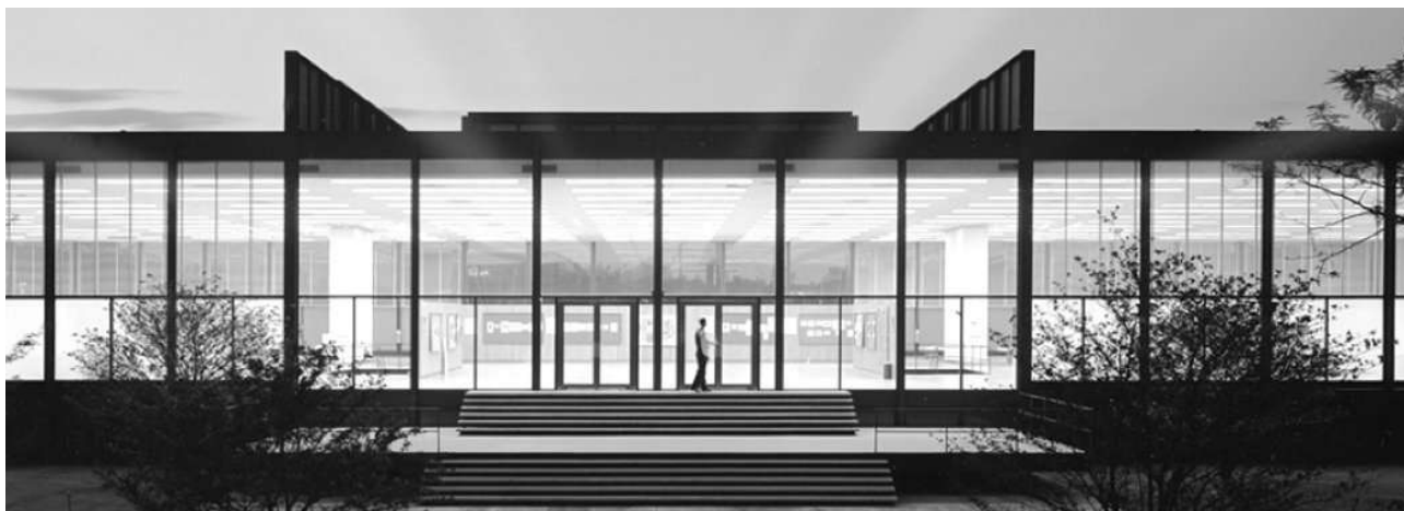
Mies van der Rohe : le Crown Hall du campus de l'Institut de technologie de l'Illinois (IIT) à Chicago dans l'Illinois, USA (1950-1956)
